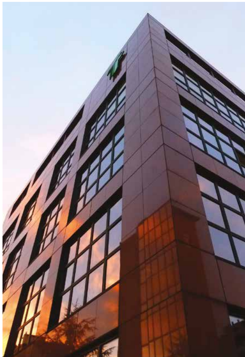
Palazzo Strale, sede TEKNE dal 1994
