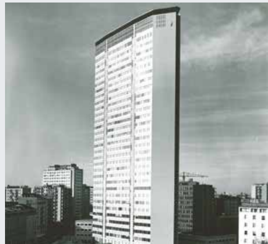
Il “Grattaciello Pirelli” in costruzione (Archivio TEKNE)
