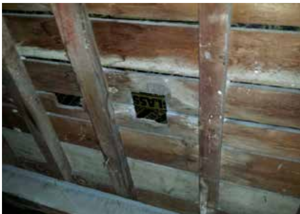
Figura 4. Vista di dettaglio: della struttura in legno della copertura inclinata della scuola "Gianelli" (a), della copertura piana della scuola "Natale Gallino" (b), della struttura in c.a. e del mattone faccia a vista della scuola "Alessandro Manzoni" (c), facciata realizzata in pannelli prefabbricati della scuola "Palli-Strozzi" (d) (© Immagini rielaborate da Clara Vite).
