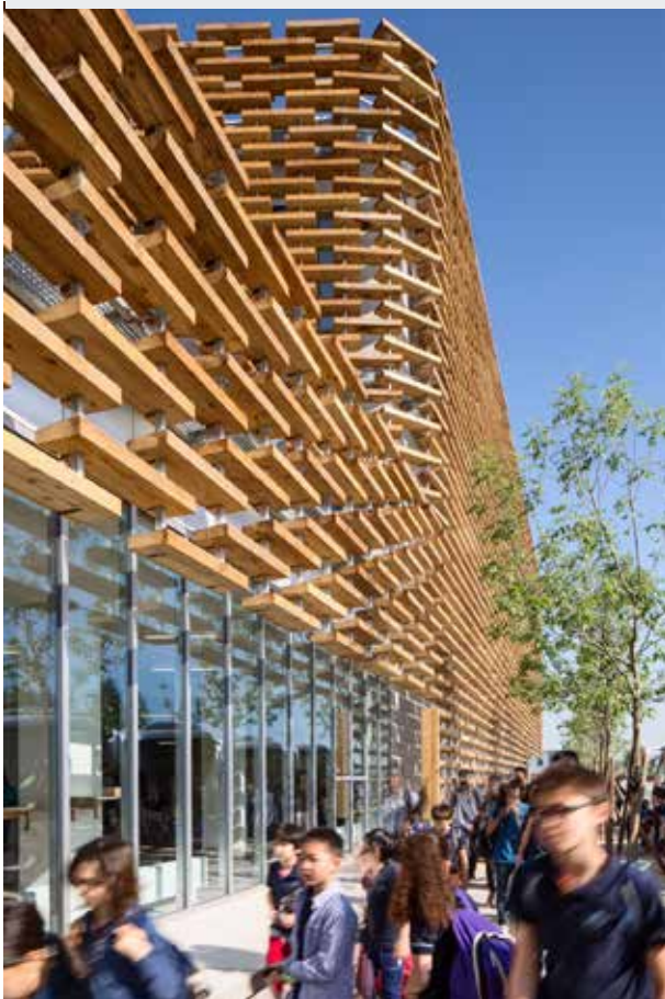
Figura 5. Esempio di sistemi di schermatura installati nella scuola internazionale francese di Pechino, Jacques Ferrier Architecture. (Crediti Fotografici: Luc Boegly)
