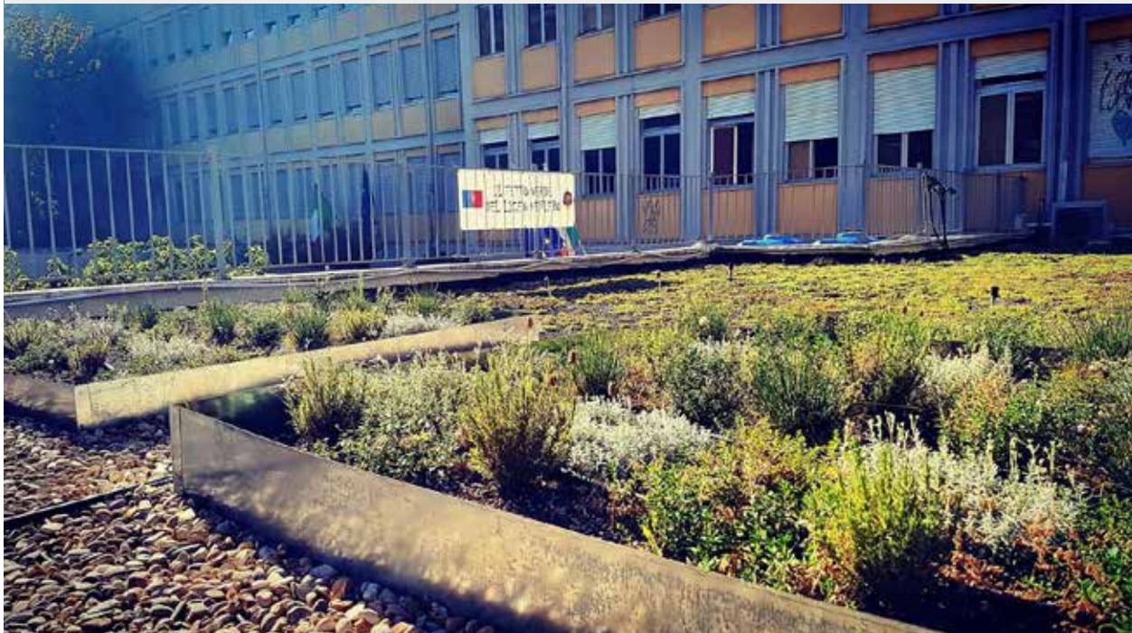
Figura 4. Esempio di tetto verde realizzato nel Liceo Keplero di Roma, primo esempio di copertura verde realizzata in un edificio scolastico, nell'anno 2016. (Fonte: https://www.greenroofs.com , crediti fotografici: Roberto Casalini)
