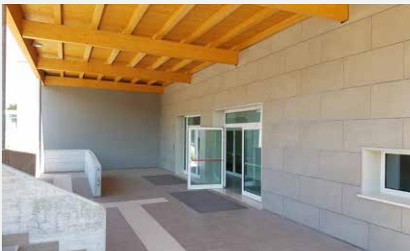
rigido autoestinguente rivestito da una lamina in alluminio gofrato e da un correntino asolato in acciaio protetto integrato nel pannello in fase produttiva. Il correntino, creando un'orditura metallica portante, risulta funzionale al fissaggio del rivestimento esterno e, al tempo stesso, crea la camera di ventilazione fra la cortina esterna e l'isolante.
