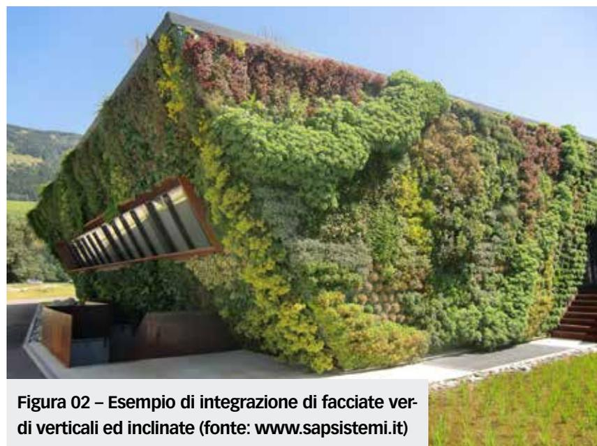
**Figura 02 – Esempio di integrazione di facciate verdi verticali ed inclinate (fonte: www.sapsistemi.it)**
