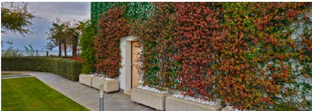
**Figura 03 – Esempio di soluzione di parete verde con verde rampicante su apposita sottostruttura ([www.geoplastglobal.com](http://www.geoplastglobal.com))**
