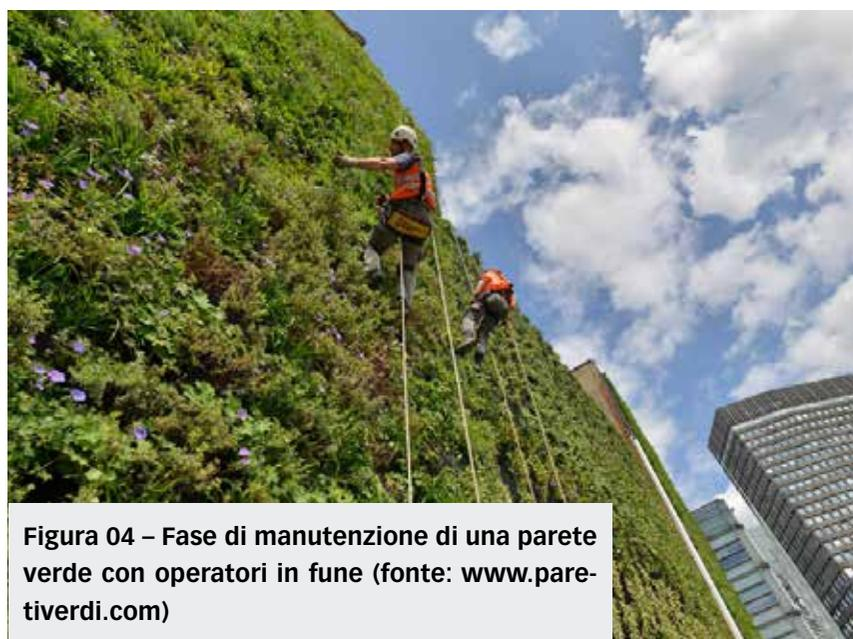
**Figura 04 – Fase di manutenzione di una parete verde con operatori in fune (fonte: [www.pareteverdi.com](http://www.pareteverdi.com))**
