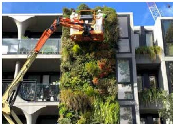
**Figura 10 – Living Wall e sistema di accesso in facciata per operazioni di manutenzione periodiche (fonte: <https://fytogreen.com.au>)**
