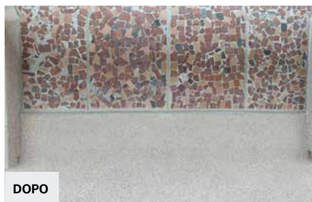
Restauro pannello prefabbricato
