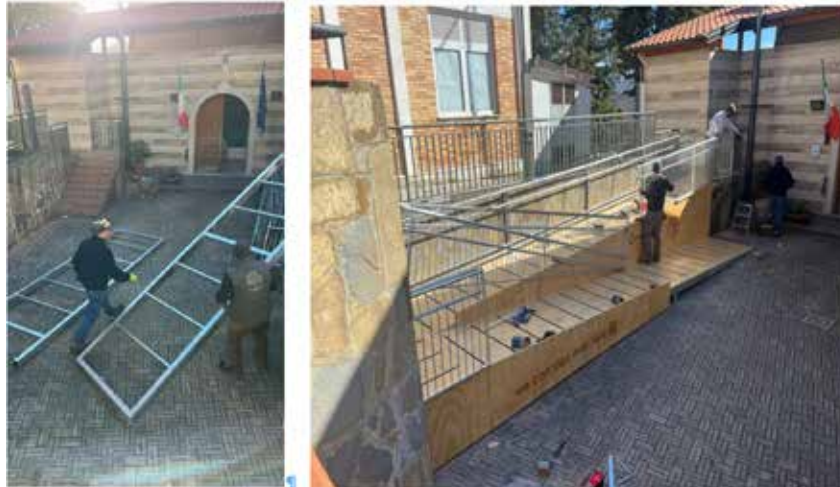
Figura 11 – Montaggio della rampa di accesso per il superamento della barriera architettonica della scala di ingresso al viale dove affaccia l'ingresso principale del CamminHub (Oliveto Lucano, Provincia di Matera)
