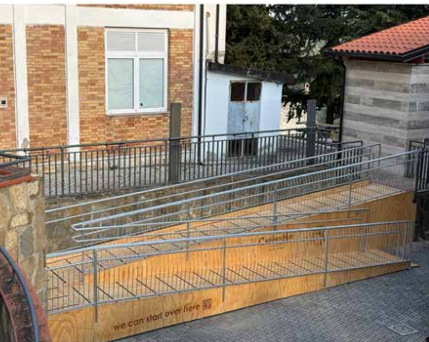
Figura 13 – Vista dall'alto della rampa di accesso al CamminHub (Oliveto Lucano, Provincia di Matera)
