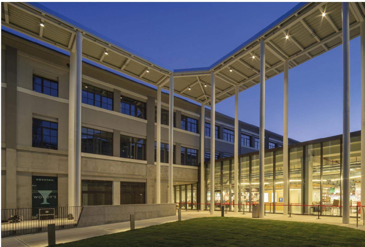
non lasciano spazio alla decorazione. Il sistema portante è costituito da uno scheletro in cemento armato realizzato in opera.
