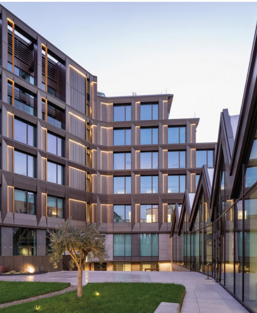
La parte alta è invece caratterizzata dall'utilizzo di imbotti verticali in alluminio anodizzato brunito, differenza utile a identificare le parti in sopraelevazione e a frammentare le dimensioni dell'edificio.
