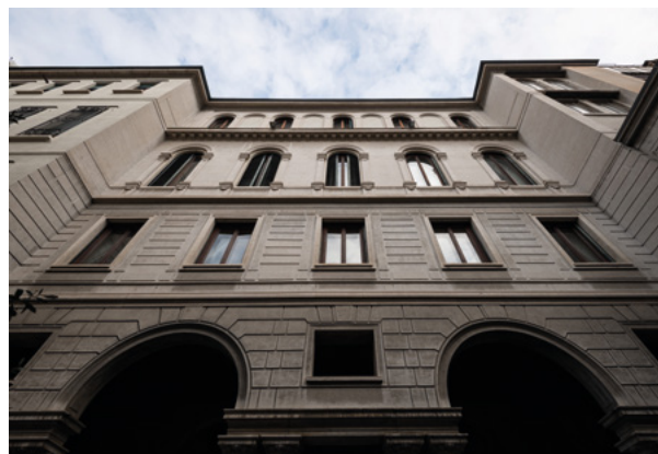
La facciata su via Palestro prima dell'intervento (credits: Stefano Gusmeroli)
