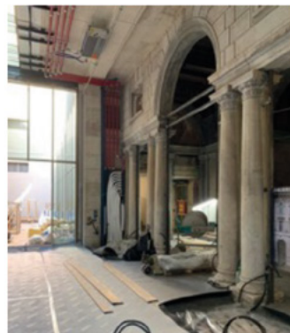
L'intervento nel cortile / atrio: traslazione della facciata e chiusura con copertura vetrata
