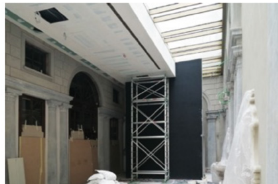
L'intervento nel cortile / atrio: traslazione della facciata e chiusura con copertura vetrata
