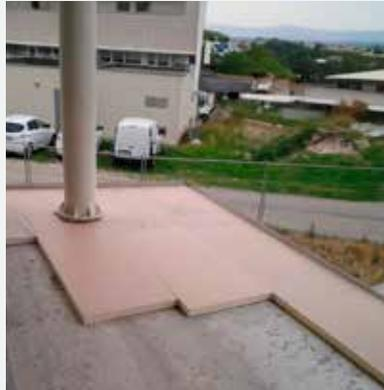
meabili. Per le parti di copertura piana, con inclinazione inferiore al 10%, il fissaggio è avvenuto mediante colla a freddo ed è stato utilizzato il pannello STIFERITE Class S rivestito da velo di vetro saturato. La posa a freddo rappresenta una soluzione efficace per ridurre le emissioni in fase applicativa e limitare il rischio incendi delle lavorazioni a caldo o con fiamme libere.
