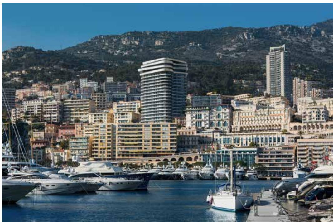
La ristrutturazione sostituisce i due piani superiori della torre (che avrebbero richiesto i lavori di ricostruzione più estesi) con tre nuovi piani sostenuti dalla struttura esistente dell'edificio. L'introduzione di questi nuovi piani mantiene la struttura originale del 1963 e crea sei nuovi attici con una vista impareggiabile sul porto di Monte Carlo.
