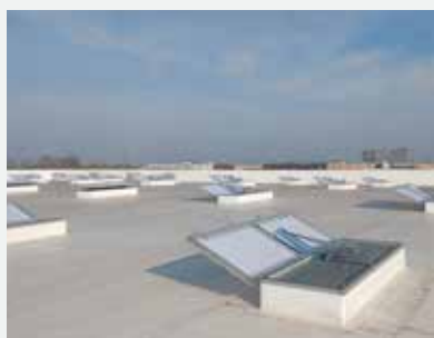
IL SISTEMA ENFC SMOKE ARIES® FUNZIONA A BASSISSIMA TENSIONE
