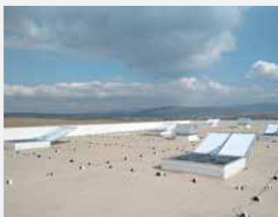
I DISPOSITIVI SMOKE ARIES® POSATI SU UN TETTO DI UNO STABILIMENTO INDUSTRIALE
