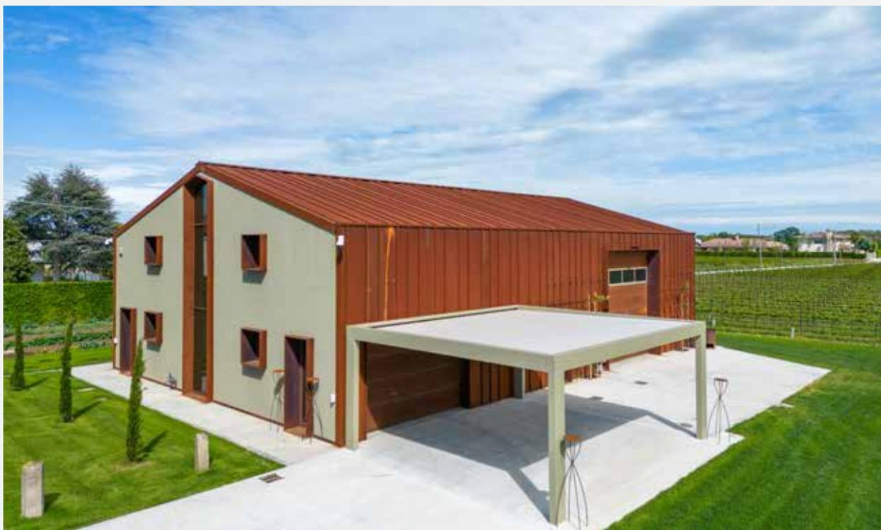
lunghe sono avvolti in lastre Alugraf di Alubel, realizzate in acciaio cor-ten spesso 8/10 mm.
