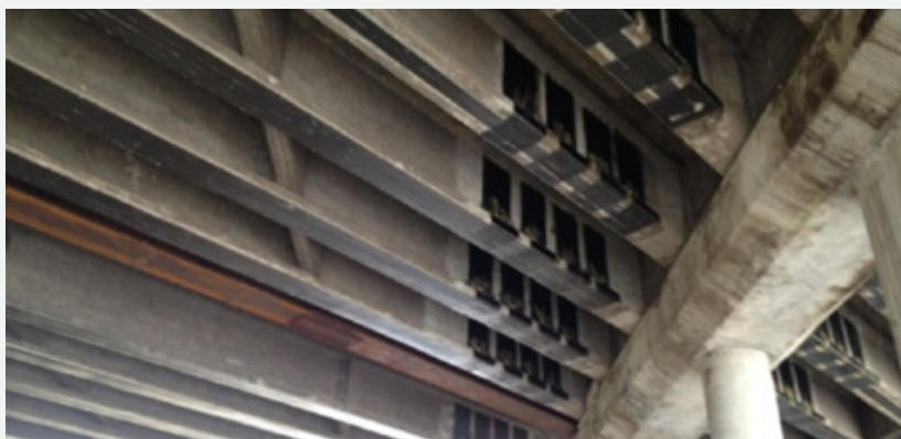
FIGURA 4 – SCHEMA DI DISPOSIZIONE DEL RINFORZO CFRP
