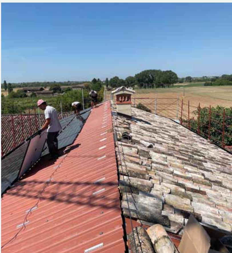
In occasione della manutenzione straordinaria delle coperture di due edifici residenziali si è scelto di recuperare i coppi in laterizio esistenti, che sono stati riposizionati sulle nuove strutture in legno. D'altra parte, per garantire la massima efficienza energetica, si è deciso di installare un impianto fotovoltaico sui tetti. Il sistema sottocoppo di Alubel è stata la soluzione tecnica che ha soddisfatto entrambe le necessità:
