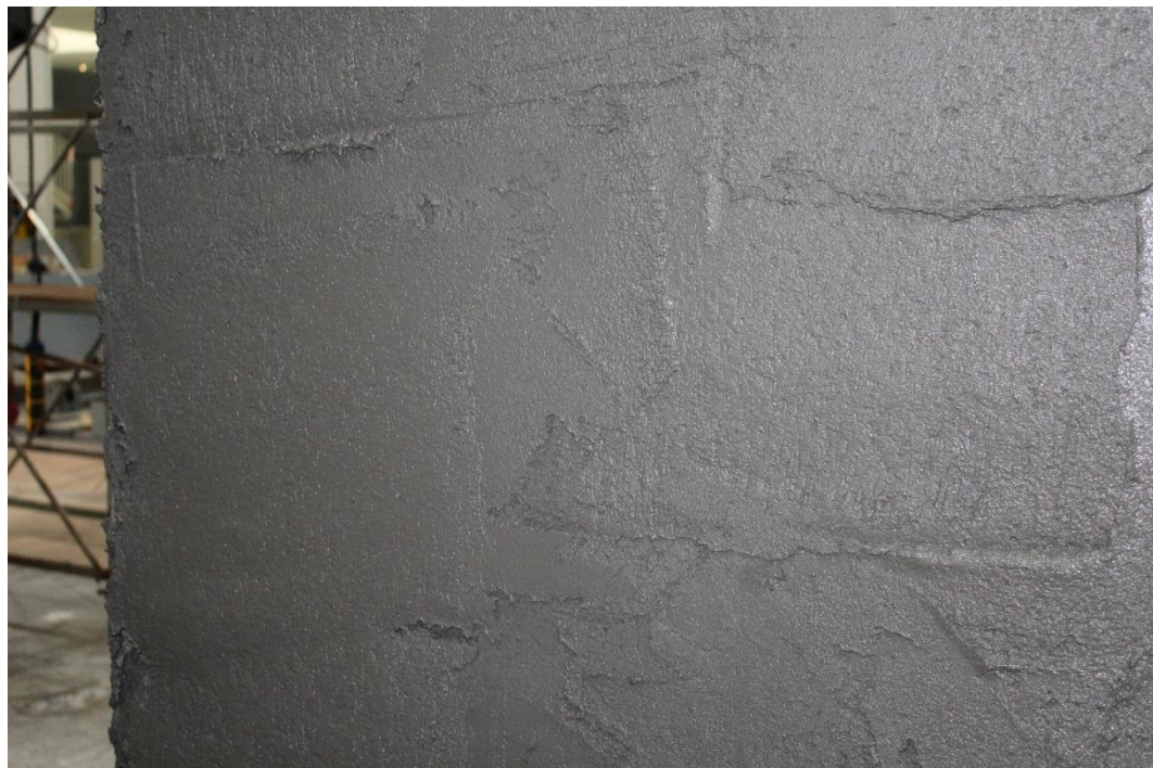
Figura 6. Posa in opera del sistema di rinforzo strutturale mediante malta MX-PVA Fibrorinforzata: immagini del prosetto C dopo la prima stesura.
