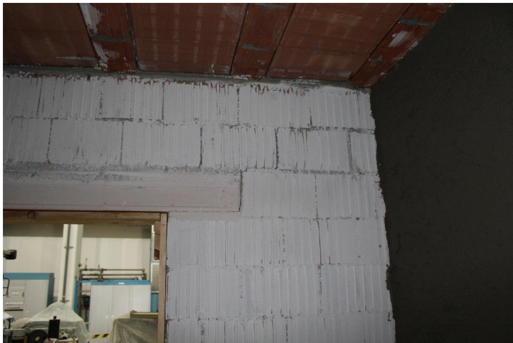
Figura 4. Posa in opera del sistema di rinforzo strutturale mediante malta MX-PVA Fibrorinforzata: dettagli di porzioni interne al modello.
