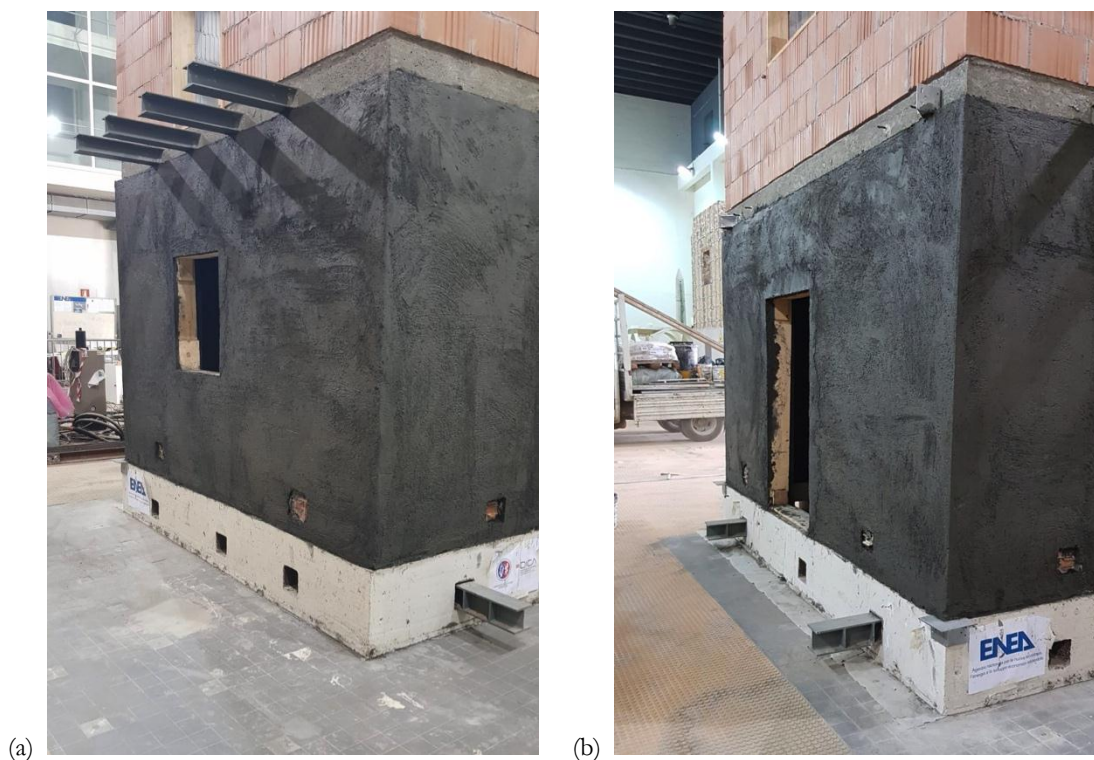
Figura 8. Posa in opera del sistema di rinforzo strutturale mediante malta MX-PVA Fibrorinforzata: immagini dei prospetti A (a) e B (b) dopo la seconda stesura.
