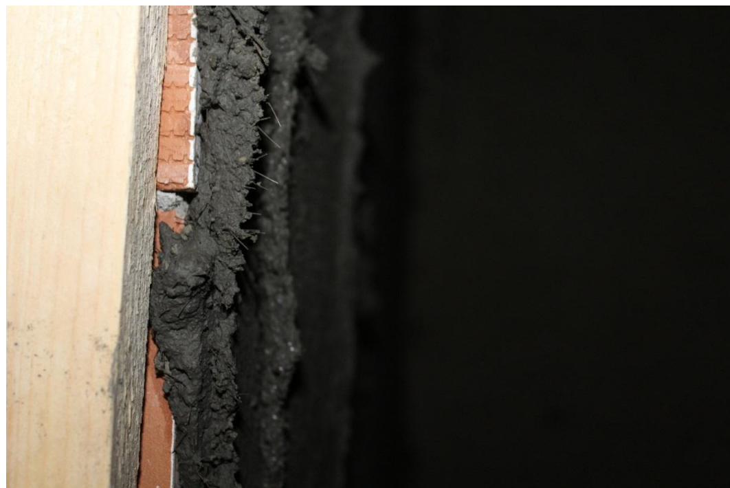
Figura 5. Posa in opera del sistema di rinforzo strutturale mediante malta MX-PVA Fibrorinforzata: immagini di dettaglio in merito alla prima stesura.
