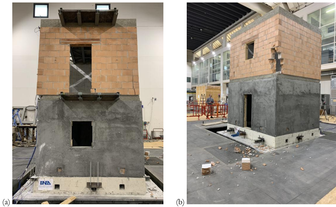
Figura 31. Danno causato dal sisma E4 – RM (fattore di scala 1.50): (a) prospetto A; (b) prospetti C e D.
