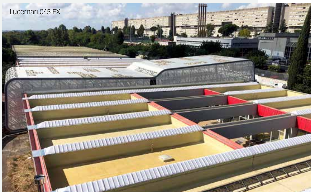
Dettaglio delle costolature del lucernario
