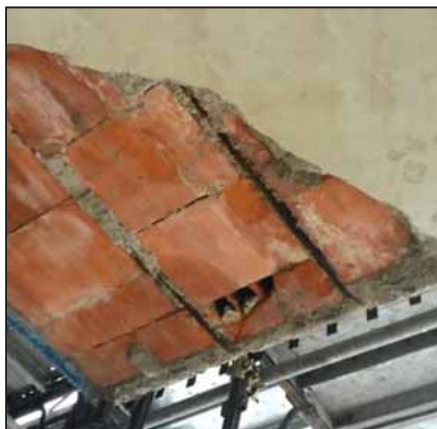
Figura 7b: Solai tipo "SAP".
