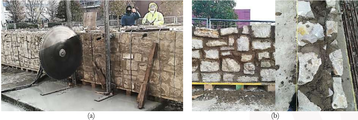
Figura 1: Paredi in muratura: (a) operazioni di taglio; (b) tessitura della muratura durante la costruzione.
