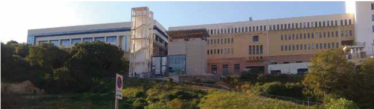
Figura 02 – TCLab Testing Envelope, sezione del BFL - Building Future Lab (Università Mediterranea di Reggio Calabria).
