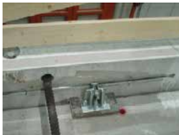
(A) – CONNESSIONE SCORREVOLE PER PANNELLI VERTICALI
