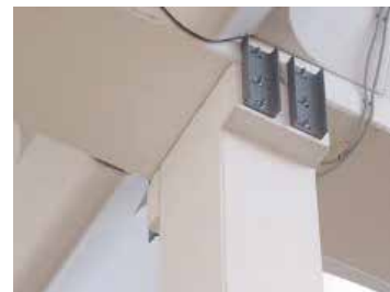
(A) – GIUNTO TRAVE-PILASTRO
