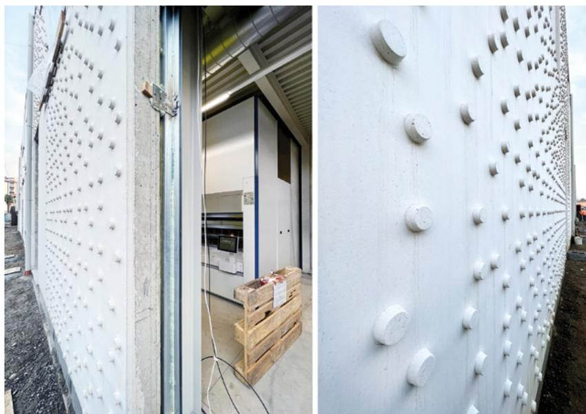
facciata un ruolo principale nella composizione del volume. I pannelli sono stati ingegnerizzati mediante l'impiego di matrici customizzate. L'alternanza di superfici lisce con finitura acidata a superfici bugnate diventano protagoniste in funzione della posizione del sole.
