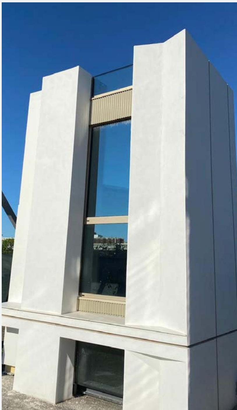
ci siamo concentrati sui giunti che ritmano le facciate cieche, riuscendo ad integrare il sistema con elementi 3Dprofil in perlite, lavorati con centri a controllo numerico, che consentissero estrema precisione sulle pose longitudinali e ortogonali.”
