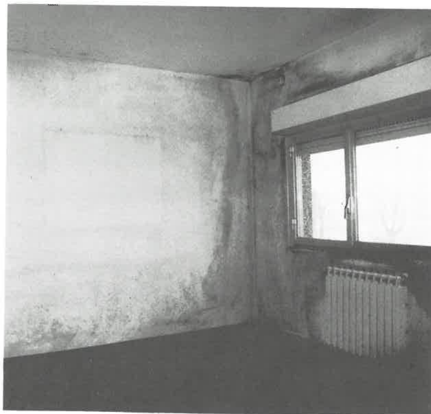
Fig. 1 - Con temperatura ambiente di 20°C e umidità relativa 35% si ha condensazione sulle superfici a temperatura inferiore a 5°C; con temperatura ambiente di 20°C e umidità relativa 70% si ha condensazione sulle superfici a temperatura inferiore al 14°C.
