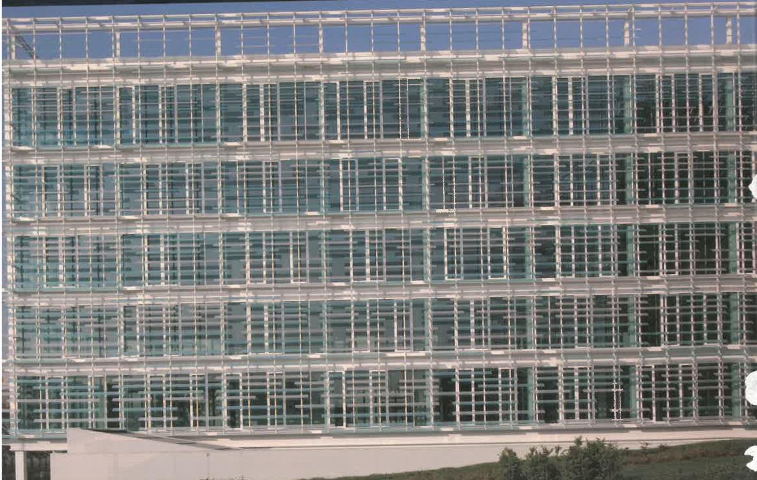
Il brise soleil riveste tutto il prospetto ovest rendendolo uniforme attraverso l'uso delle lamelle in policarbonato, montate su una struttura d'acciaio ancorata al prospetto.
