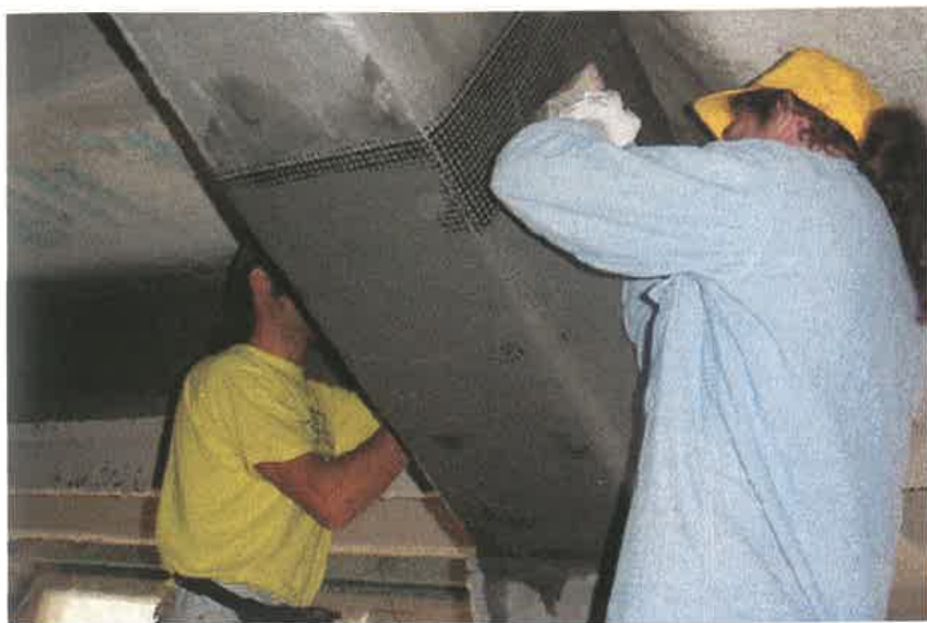
Placcaggio di una trave dello Stadio San Siro con rete di fibre al carbonio e malta epossidica.
