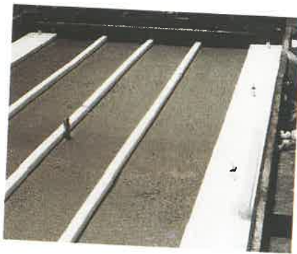
Fase di realizzazione di un pannello verticale Isocore da 12 m a taglio termico alleggerito e ventilato.
