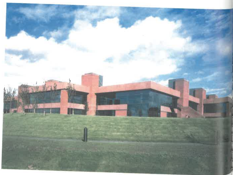
Gli edifici del terziario (palazzi per uffici, centri commerciali, parcheggi, ecc.) sono in Italia realizzati in gran parte con strutture prefabbricate in cls su maglie elevate (16x10 ad esempio) senza minimamente porre vincoli alla ricerca formale e alla caratterizzazione architettonica.
