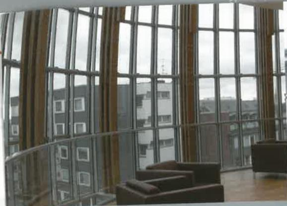
In basso, la superficie curva a "onda" della facciata è contenuta alle due estremità da due setti murari che seguono i punti di collegamento del sistema strutturale di sostegno della vetrata con gli altri volumi parallelepipedi del complesso rivestiti con elementi in ceramica bianca.
