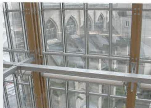
metrica degli elementi che costituiscono le unità minime di cui è costituita la superficie vetrata, il secondo riguarda le tensioni e le deformazioni derivanti dal differente comportamento dei materiali in relazione alle condizioni ambientali e di carico.
