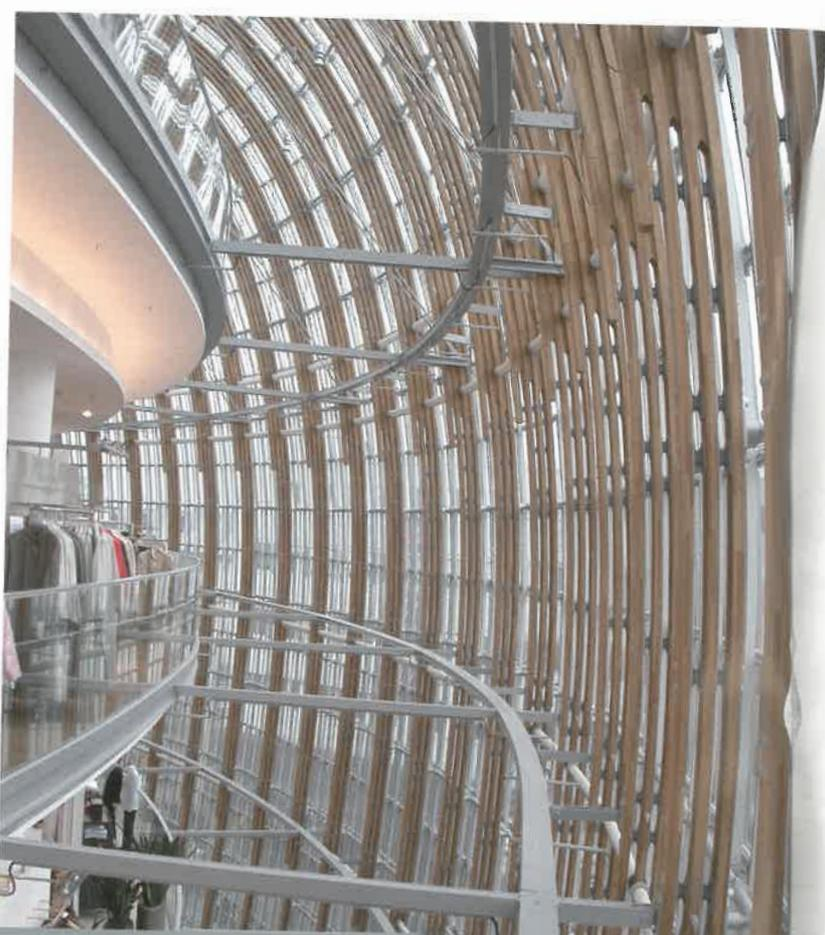
Sopra, il grande vuoto compreso tra le balconate dei piani di esposizione e la superficie curva dell'involucro vetrato è scandito dal ritmo degli elementi strutturali della facciata, costituiti dai "costoloni" composti in acciaio e legno lamellare interconnessi alla struttura dei solai intermedi dei piani espositivi con puntoni a doppia cerniera. È chiaramente visibile la rastrematura dei costoloni dall'alto verso il basso della struttura.
