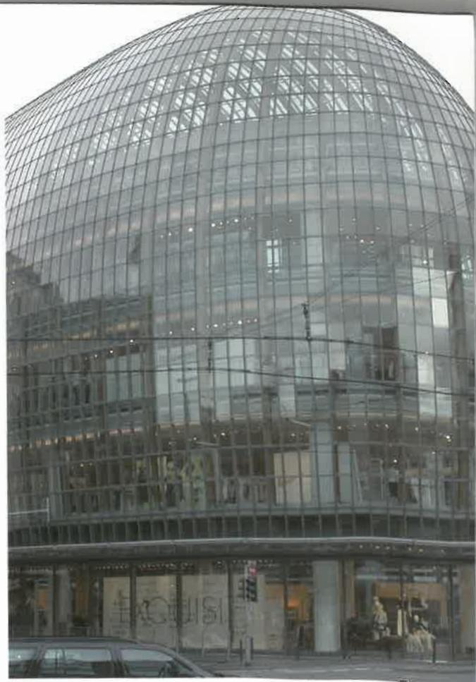
Questa struttura ha un passo di 2,5 metri ed è connessa, sul piano di giacitura dei sostegni, con i solai di ciascun piano attraverso profili metallici tesi a contenere i possibili effetti di instabilità laterale della facciata e le possibili tensioni derivanti da eventuali spinte orizzontali. Sul piano di giacitura della superficie vetrata la struttura principale è affiancata da una complessa sottostruttura metallica che sostiene le lastre trasparenti.
