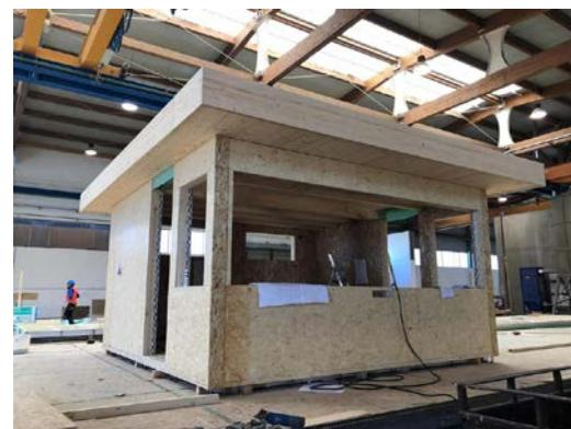
Dettaglio dei due moduli assemblati in fase di produzione.
