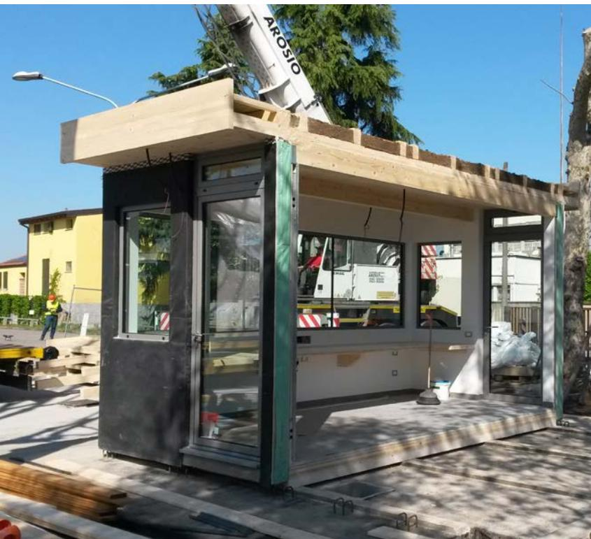
*Dettaglio del primo modulo prefabbricato posato.*
