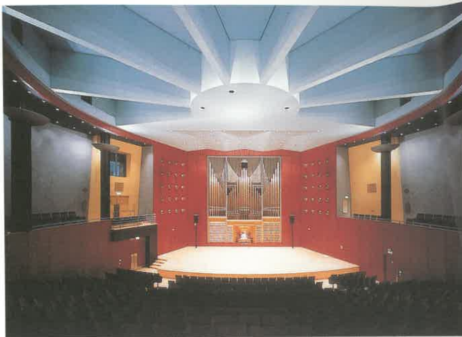
Sala riunioni Bausparkasse, Monaco. Progetto di Gunter Henn. Lo spazio destinato a convegni presenta un controsoffitto conformato in modo da alternare parti diffondenti a parti assorbenti. Il sistema STOSilent 2000 non pone vincoli dal punto di vista formale.
