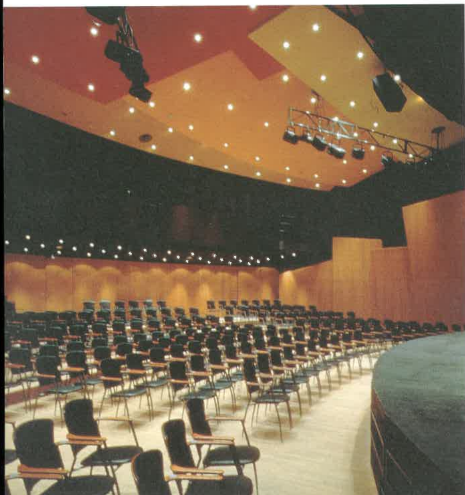
Sala riunioni Bausparkasse, Monaco. Progetto di Gunter Henn. Lo spazio destinato a convegni presenta un controsoffitto conformato in modo da alternare parti diffondenti a parti assorbenti. Il sistema STOSilent 2000 non pone vincoli dal punto di vista formale.
