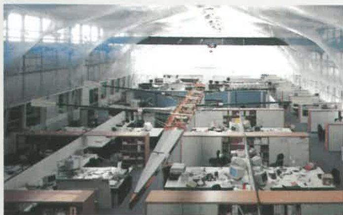
L'involucrazione degli spazi lavorativi tramite membrane regolatrici degli aspetti bioclimatici del comfort interno: un centro di ricerca in un edificio esistente.
