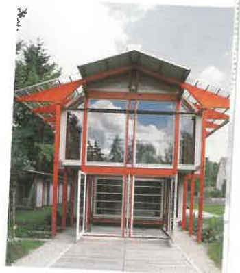
Una pensilina fotovoltaica (in alto).
