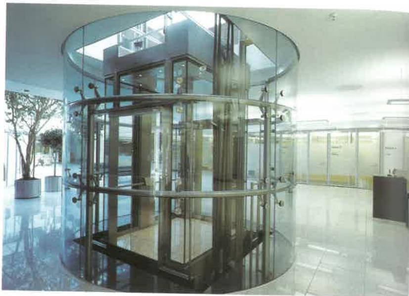
*Ascensore realizzato con vetri ricurvi e con una speciale struttura in acciaio inossidabile (Frener & Reifer Metallbau).*
