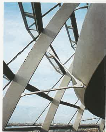
Dettaglio della struttura portante in acciaio e del tamponamento in vetro della cupola realizzata per il nuovo Parlamento al Reichstag di Berlino (progetto Norman Foster).
