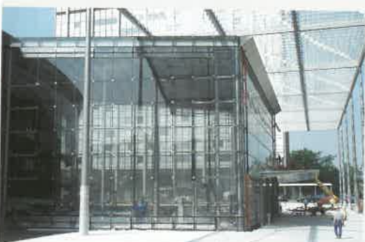
Una grande copertura inclinata in cui l'incidenza visiva dei giunti è ridotta al minimo. Progetto di Sobek Ass.
