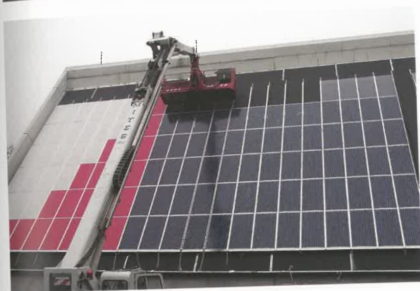
In alto: installazione dei moduli fotovoltaici.
