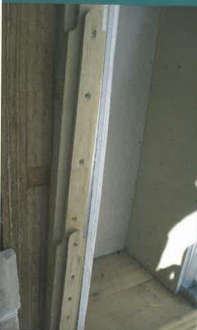
A destra, pannello portante a tavole incrociate con finitura interna in pannelli di cartongesso e finitura esterna con: superisolamento in fibra di legno pressata, guaina impermeabile, camera d'aria, pannello portante ed elementi di rivestimento in pietra faccia a vista (realizzazione Rasom Holz&Co - Pozza di Fassa TN).
