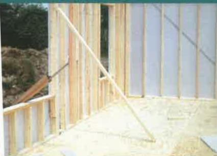
A sinistra, edificio a setti intelaiati in fase di costruzione.
