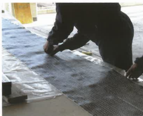
Operazioni di taglio di un tessuto unidirezionale in fibra di carbonio (BASF).
