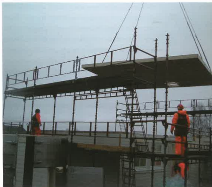
Posa in opera di un solaio platform frame interamente realizzato a piè d'opera.
