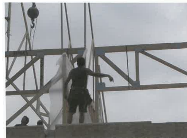
Installazione in opera di capriate leggere su trave reticolare longitudinale leggera in un cantiere a Montreal (Canada).
