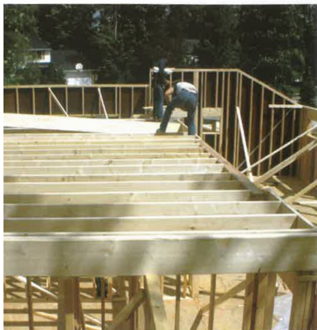
Realizzazione di un solaio a ordito più impalcato col sistema transform frame.
