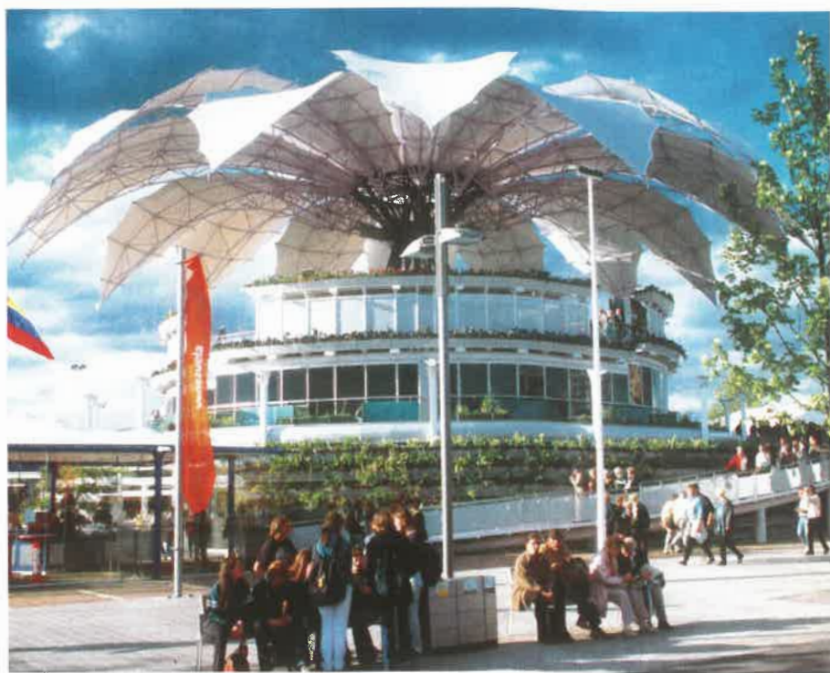
In alto e in basso a destra: Padiglione del Venezuela all'EXPO di Hannover 2000. In questa struttura la copertura poteva aprirsi o chiudersi al variare delle condizioni climatiche o delle precipitazioni piovose, con lo scopo di creare una interazione tra l'architettura e i cambiamenti ambientali. (Immagine per cortesia dello Studio SL – Rasch, Stoccarda, Germania).
