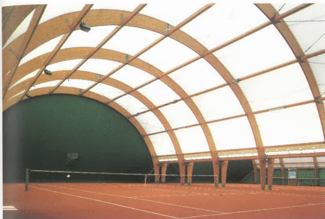
A.S.L.I. riconosce tre tipologie (adottate dalla normativa UNI): la tenda-struttura (a sinistra un esempio di tenda-struttura con ossatura costituita da travi lamellari, mentre nella pagina a fianco un esempio di tenda-struttura con ossatura costituita da una maglia reticolare in acciaio), la tenso-struttura (in questa pagina al centro) e la presso-struttura (in basso).
