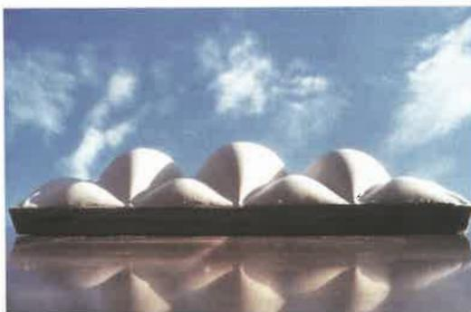
*Modelli di studio della forma di strutture pneumatiche. Partendo da forme sferiche semplici è possibile produrre una incredibile varietà formale e tipologica di strutture pneumatiche attraverso, ad esempio, la suddivisione della struttura di partenza con cavi e maglie di cavi, associata all'applicazione di ulteriori tensioni localizzate (da Frei Otto e Bodo Rasch, Finding Form, Edizioni Menges, 1995).*
