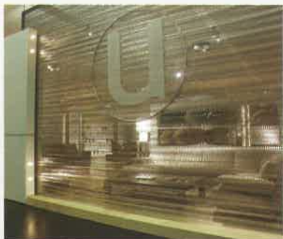
La rete metallica intelaiata e appesa in modo da creare dei diaframmi permeabili al passaggio della luce.
