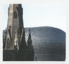
so un controllo preciso di ogni singolo disco semplificando la fase di cantierizzazione che è diventato un momento di assemblaggio poco complesso. Questi dischi rispondono inoltre all'esigenza di economicità della costruzione, presen-
