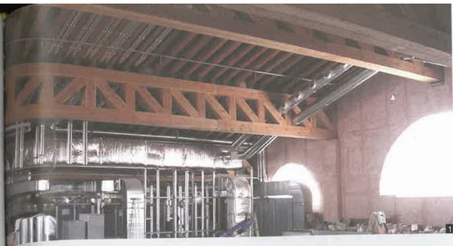
1. Le travi reticolari in legno che reggono la copertura delle Sale Apollinee.
