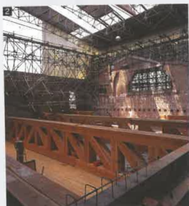
4. Vista della struttura di sostegno della volta della Sala Teatrale. Si possono notare le travi composte in legno tipo Vierendeel, i pendini di collegamento per la sospensione della volta, la sottostruttura in legno e le centine della volta.
