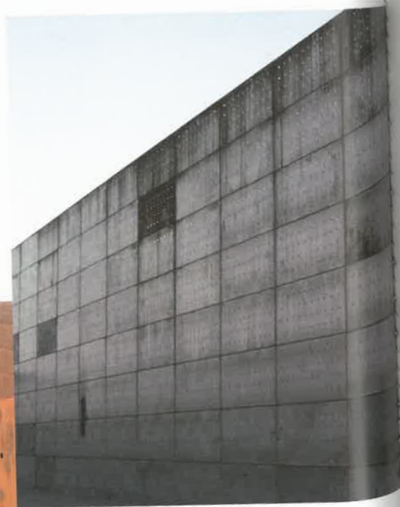
Sopra: la facciata del Centro Divertimenti Stop Line come appare dopo l'assemblaggio delle lastre. Il Corten, appena uscito dalla fonderia, si presenta con il caratteristico colore dell'acciaio per assumere, solo in un secondo momento, la tipica colorazione "rugginosa" (Foto di Studio Archea).
