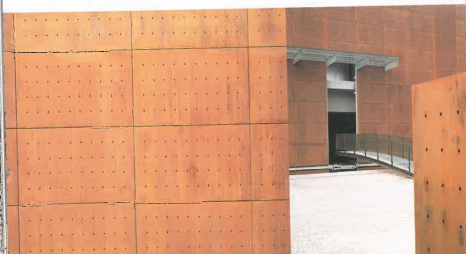
Sopra: la facciata del Centro Divertimenti Stop Line come appare dopo l'assemblaggio delle lastre. Il Corten, appena uscito dalla fonderia, si presenta con il caratteristico colore dell'acciaio per assumere, solo in un secondo momento, la tipica colorazione "rugginosa" (Foto di Studio Archea).
