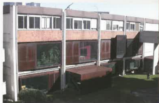
In alto: nella vista d'insieme spiccano i moduli di facciata in acciaio corten. Al secondo piano è ancora visibile il precedente trattamento del prospetto.
