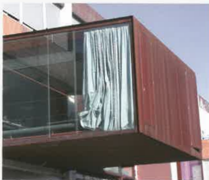
In alto: nella vista d'insieme spiccano i moduli di facciata in acciaio corten. Al secondo piano è ancora visibile il precedente trattamento del prospetto.
