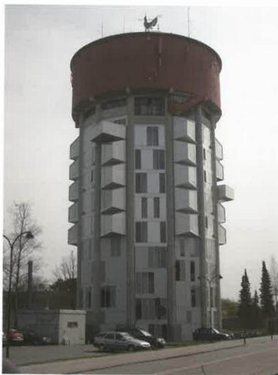
Recupero di una torre piezometrica a Jaegerborg.
