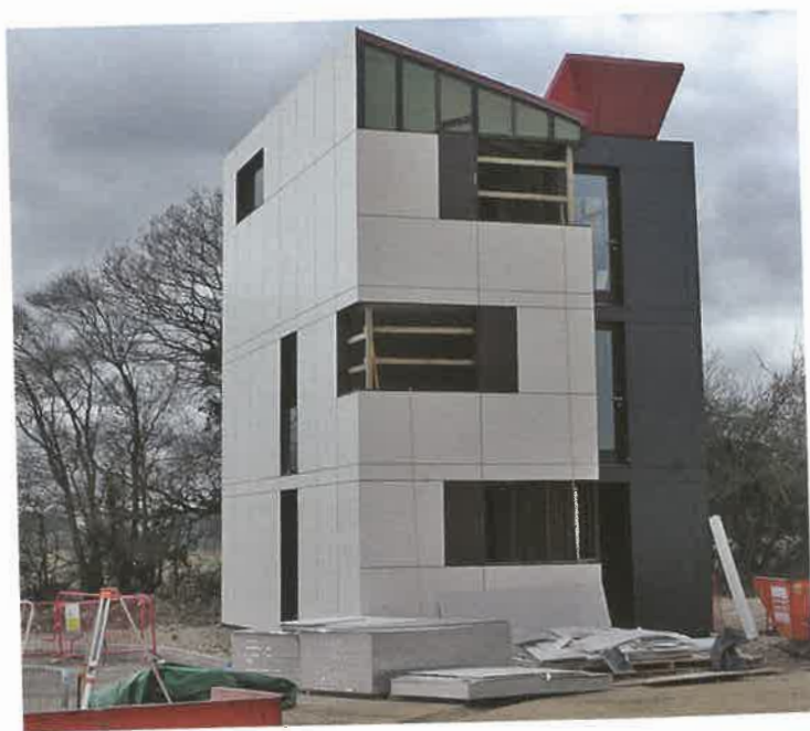
Rogers Stirk Harbour & Partners: Eco-Residenze, Oxley Woods a Milton Keynes. La struttura in legno permette la realizzazione in stabilimento di importanti porzioni di edificio che vengono trasportate in situ e assemblate in tempi rapidi grazie alla leggerezza dei singoli elementi e al ricorso a nodi studiati per semplificare le lavorazioni in opera. (A destra lo schema del montaggio).
