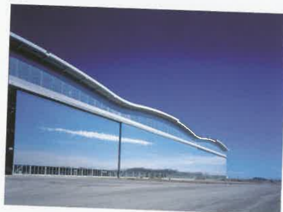
Sotto, Luc Henry JR, Inceneritore, Perpignan, 2004. Il rivestimento metallico è stato studiato in stretta collaborazione progettista/industria delle costruzioni, consentendo di "customizzare" il prodotto standard per questo progetto.
