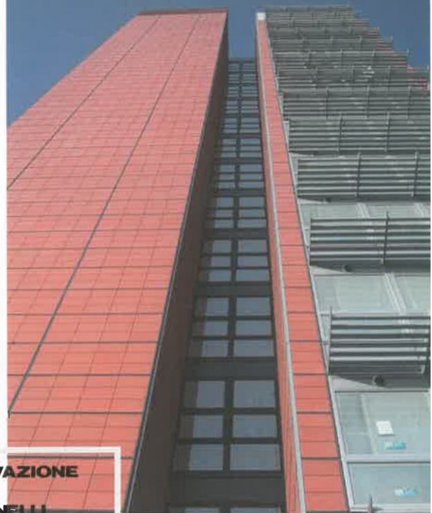
Richard Rogers, National Graduate Institute for Political Studies (G.R.I.P.S), Tokyo, 2005. La prefabbricazione dei pannelli in cotto consente precisione e controllo del processo edilizio in fase esecutiva e di cantiere.
