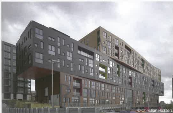
L'edificio consiste in tre corpi di fabbrica sfalsati in modo irregolare per creare due aggetti di 9 metri alle estremità.
