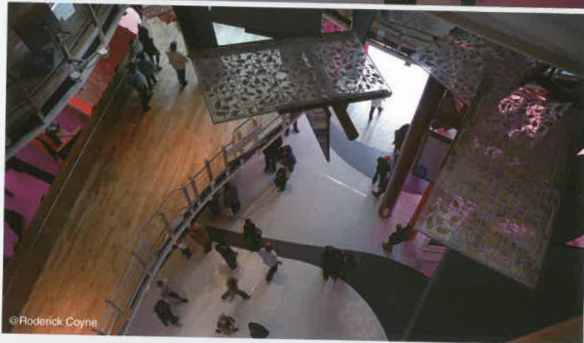
La struttura è composta da 13 coppie di pilastri in cemento a cui si ancorano, a sbalzo, gli elementi in acciaio che sostengono gli oggetti scultorei galleggianti.
